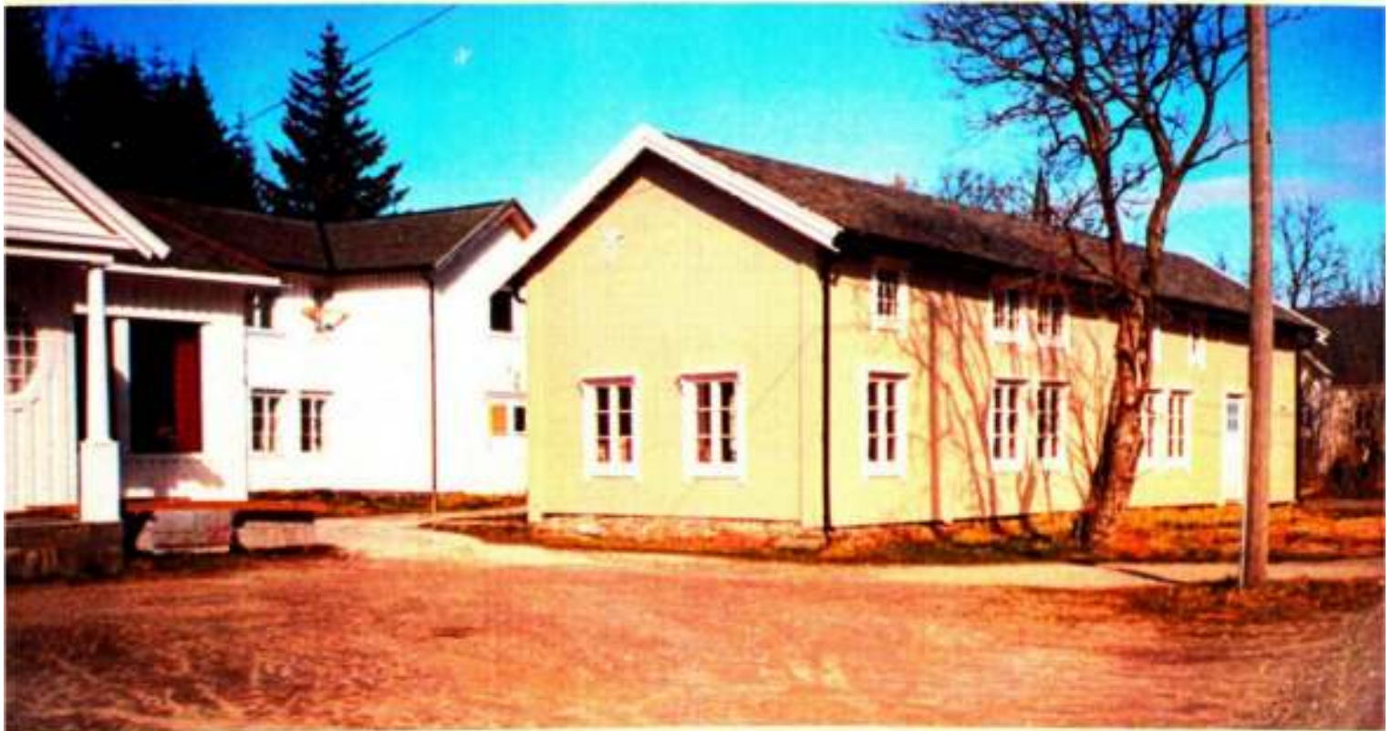
"ANDERS LARSA-STUA" sto ferdigrestaurert utvendig våren 1999
